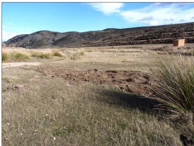
Acequias artificiales tapadas. Obras de restauración del río Salobre (Teruel).
