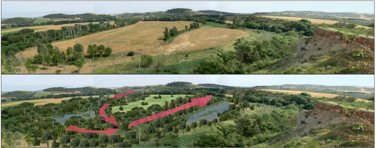
Imagen de la situación antes de la actuaciones (arriba) e imagen de los objetivos de la restauración (debajo). Foto: Gobierno de Navarra y CEDEX
