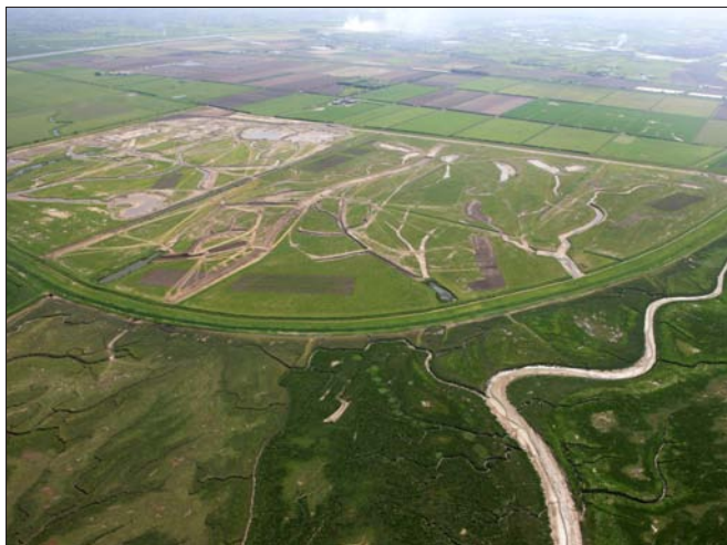
Obras de restauración en la marisma de Hesketh. Foto: RSPB
