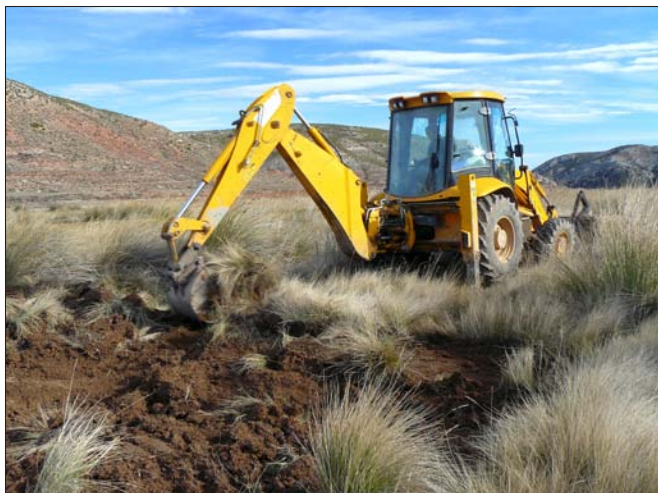
Rotura de las acequias. Obras de restauración del río Salobre (Teruel). Foto: SEO/BirdLife
