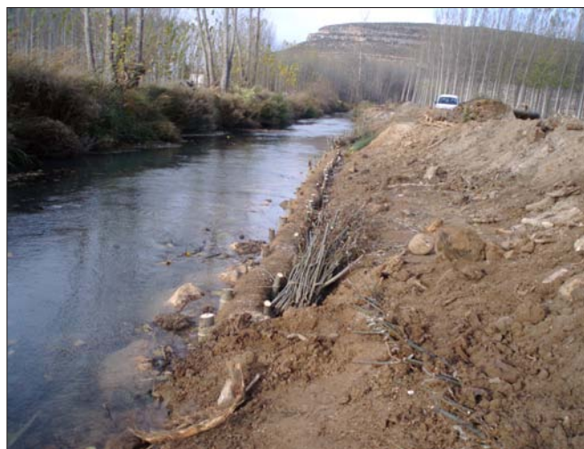
Reperfilado de orillas y perfil transversal en el tramo de Llumes. Foto: Alfonso Calvo (CHE)
