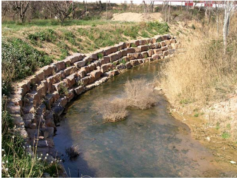
Escollera en el cauce del río Huerva. Foto: Alfredo Ollero
