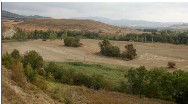
Tendido de taludes. Foto: Gobierno de Navarra y Cedex
